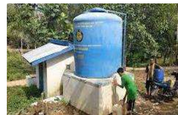
Pembangunan Sumber Air Bersih 48 Unit
