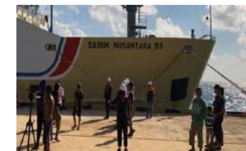
Rehabilitasi Sarana Pelabuhan 2.536,5 M2
