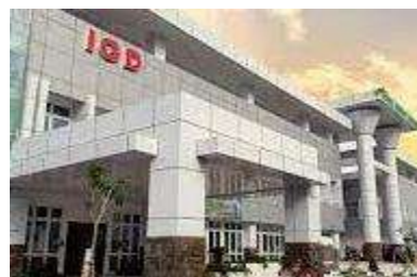
Pembangunan Gedung Rumah Sakit 3 Paket
